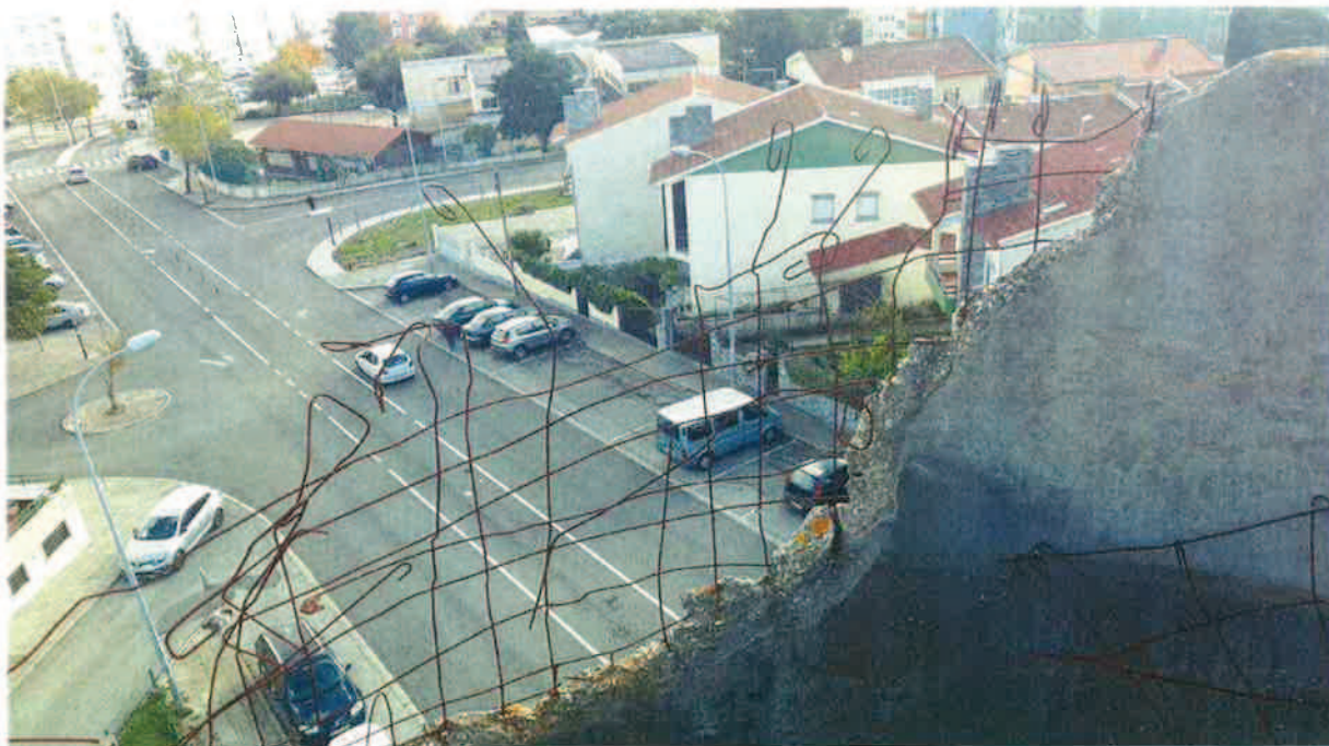
Parede superior do depósito pontualmente demolida
