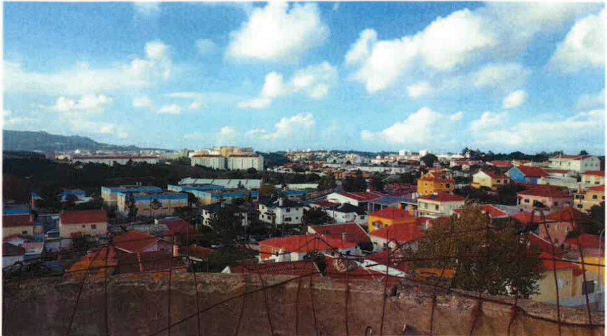
Vista do miradouro, com os restos da armadura antiga laje de cobertura do depósito
