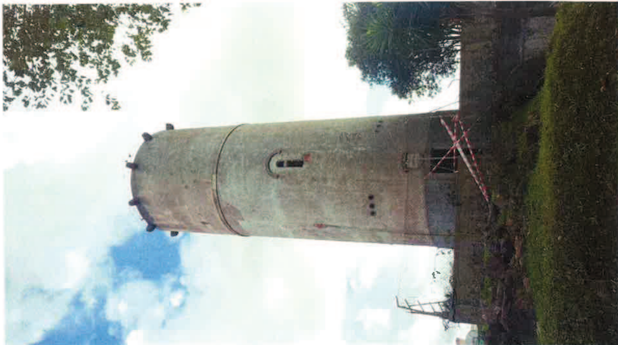
Antigo geral do antigo depósito de água
