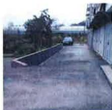
Na sequência do pedido formulado pelos proprietários das garagens, foi lançada e já concluída a empreitada adjudicada à empresa "Área Cosmopolita, Lda.". Com esta empreitada foi construído um muro de contenção em blocos de cimento com altura útil de 0,75m numa extensão de 15m, destinado a melhorar as condições de acessibilidade às garagens aí existentes.
